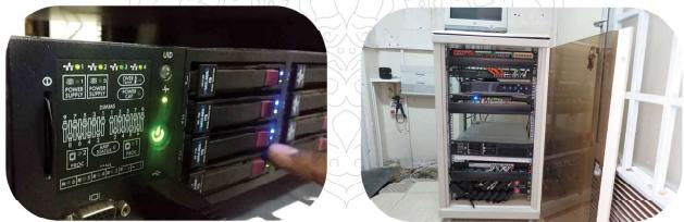
تجهیزات اتاق سرور و ارتقاء سخت افزاری و نرم افزاری سرور شهرداری (شامل مجازی سازی ، بک آپ گیری خودکار ، فایروال های امنیتی و آنتی ویروس ، اصلاح ساختار رک و کابل کشی ، اصلاح ساختار UPS ، خرید و نصب کابینت باتری ، اصلاح سیستم سرمايش و تهویه هوای اتاق سرور ، خرید رم و هارد و سایز اقلام و تجهیزات سرور ، اصلاح ساختار شبکه داخلی شهرداری و ...)
